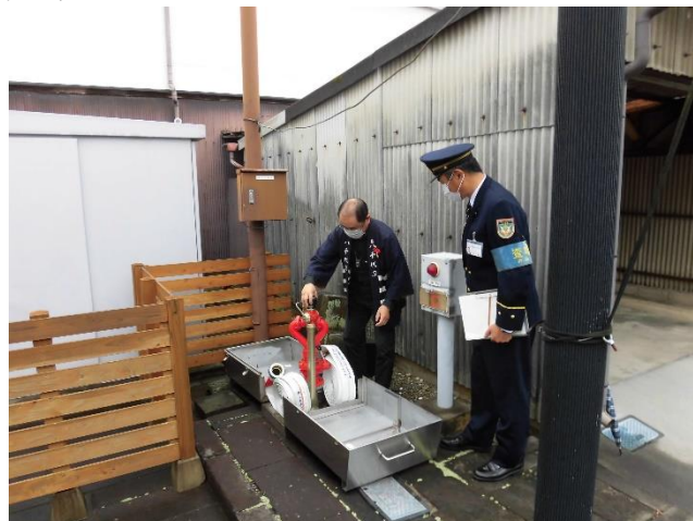
放水銃の維持管理状況の確認
