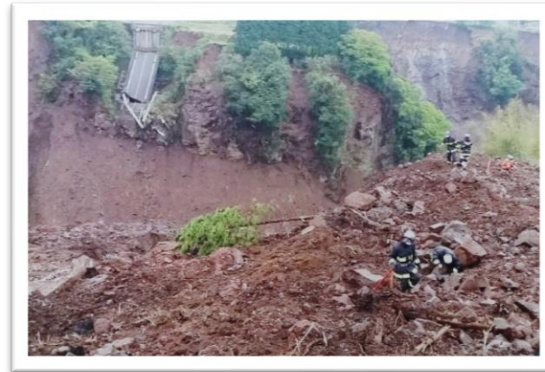
阿蘇大橋崩落現場
